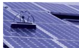
PULIZIA PANNELLI FOTOVOLTAICI
